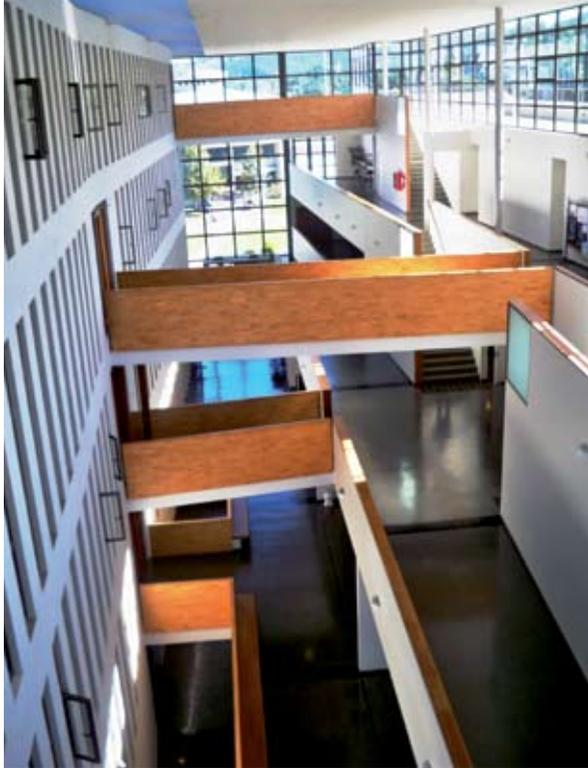
El hall o pasillo tiene 12 metros de ancho y 90 m de largo. Ambos edificios son conectados por 5 puentes o pasarelas peatonales, que corresponden a vigas de hormigón, con barandas metálicas de 1,20 m de ancho y una longitud máxima de 12 m (el largo varía por puente).
