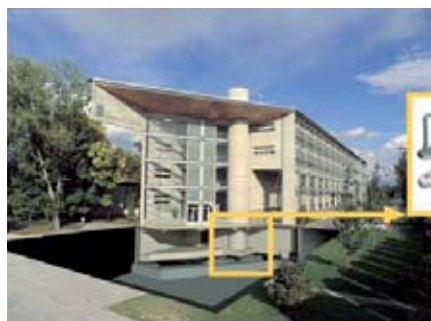
Edificio San Agustín, PUC. La estructura cuenta con 53 aisladores sísmicos.
