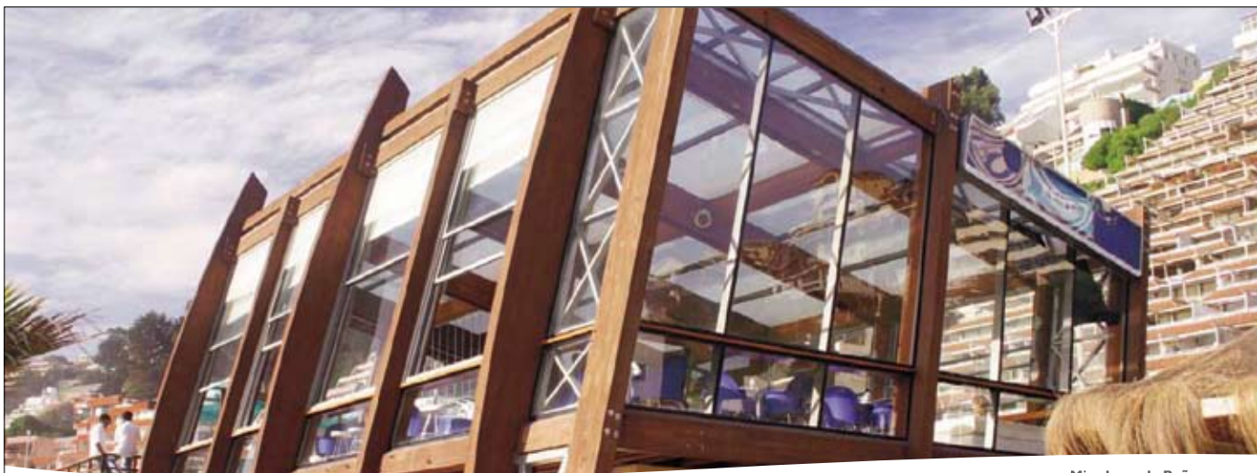
Miradores de Reñaca Arquitectos: Quiroz y Puelma
