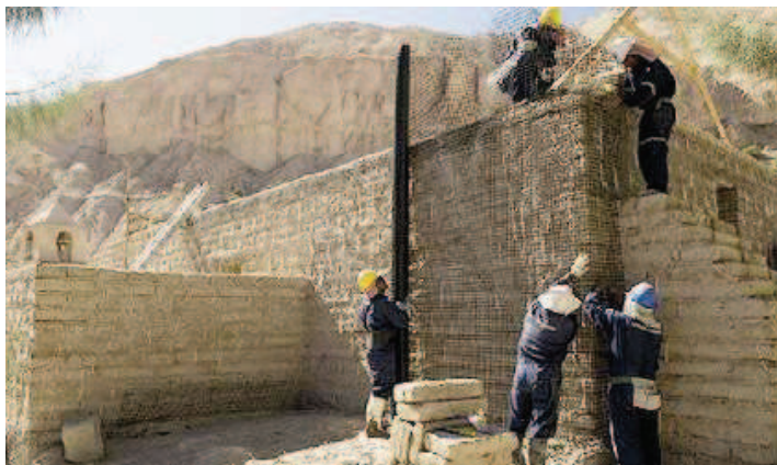
Restauración Iglesia San Pedro Esquiña, Arica – Reforzamiento con geomalla
