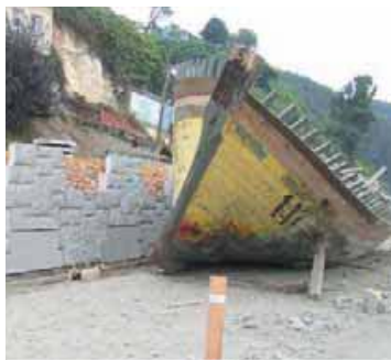
Muro en montaje al momento del tsunami
