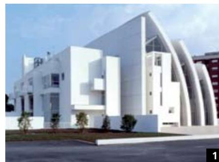
ducción iniciada por la fotocatalisis, transforman los óxidos de nitrógeno en sales de nitrato de calcio y los compuestos orgánicos volátiles como el benceno y el tolueno, se convierten en agua y dióxido de carbono. El mismo fabricante ofrece otro tipo de cemento que por el efecto fotocatalítico descompone la suciedad biológica, autolimpiándose. [www.fym.es](http://www.fym.es)
