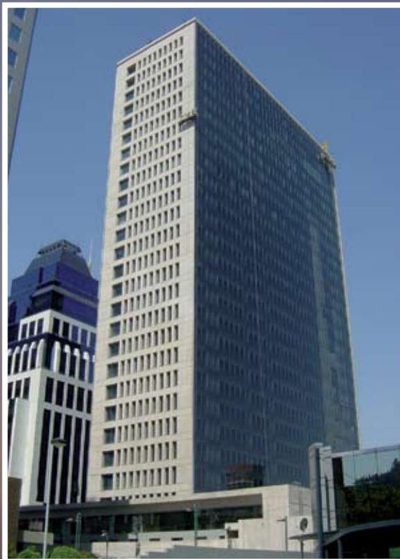
La fachada poniente es mucho más pétreo que la oriente. Destaca por ventanas "tragadas" y grandes muros de hormigón.
