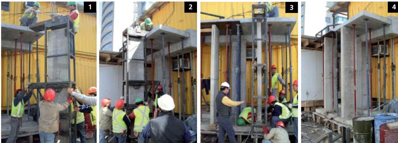
**PASO A PASO DE LA COLOCACIÓN DE LOS QUIEBRAVISTAS.** 1. Se levantan verticalmente y se introducen en la máquina. 2. Se cuelgan de la losa, quedando a la altura requerida. 3. La celosía se desplaza hacia el interior por medio de los rieles del canastillo. 4. Se termina la faena anclando el quebravista entre piso y cielo.
