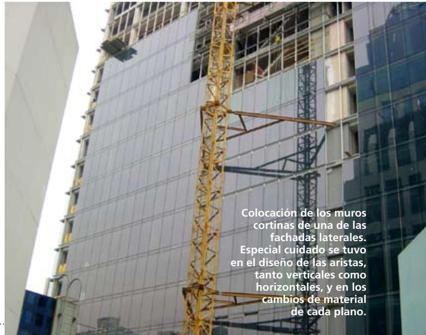
Colocación de los muros cortinas de una de las fachadas laterales. Especial cuidado se tuvo en el diseño de las aristas, tanto verticales como horizontales, y en los cambios de material de cada plano.
