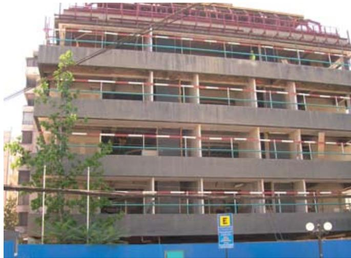
En esta secuencia se aprecia el antes y el después de la remodelación: Toda la línea de cristales se desplazó hacia el plomo del edificio, y a 60 cm se puso la doble piel. Se ganó espacio interior, se eliminaron las barandas, las losas se alargaron, por lo que el edificio cuenta con cinco pisos completos como si fueran un solo bloque.
