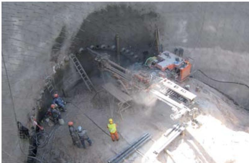
**Con la utilización de aditivos líquidos para fortificación se minimiza la generación de polución, se reducen los tiempos de carguío, además de conferir un alto grado de resistencia e impermeabilización.**
