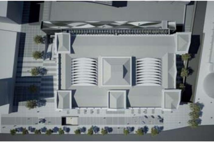
La cubierta de los patios cumple una doble función: matizar la luz del norte y aprovechar esta orientación para instalar células fotovoltaicas que complementen el suministro energético eléctrico.
