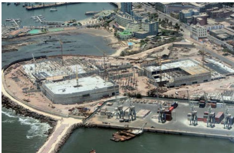
GENTILEZA CONSTRUCTORA TECTSA S.A.
