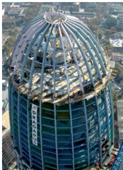
Estructura metálica empleada en la cúpula.
