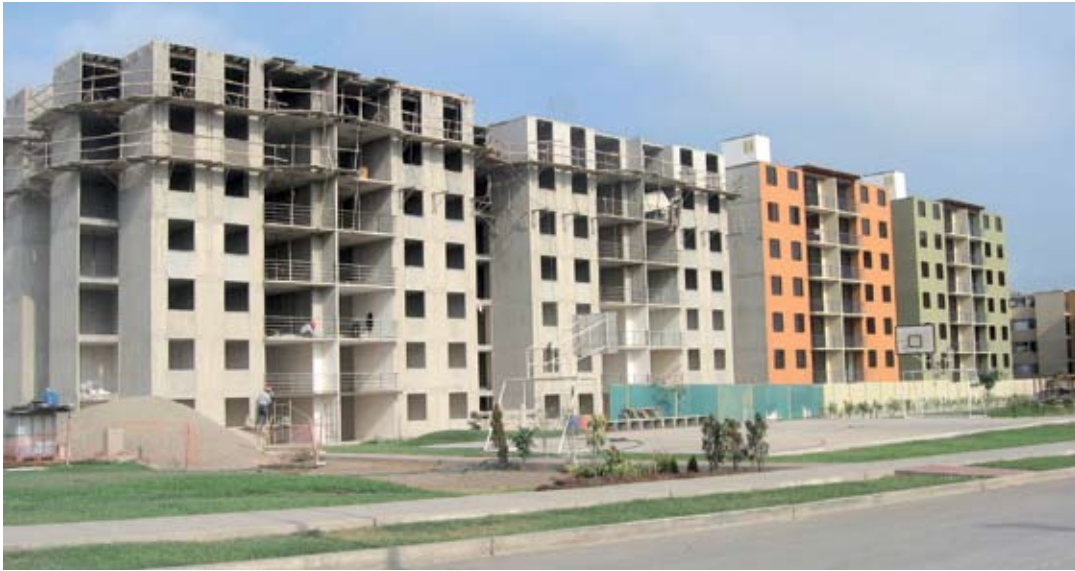
La Constructora Besalco ha realizado más de 100 edificios residenciales en Perú.
