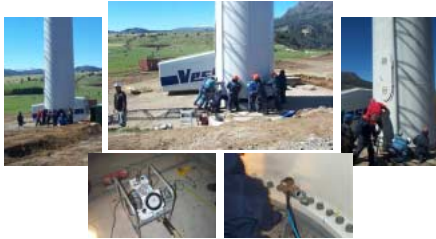
MONTAJE : SECUENCIA DE INSTALACION PRIMERA SECCION DE TORRES
