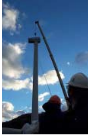
MONTAJE : CASA DE MAQUINAS
