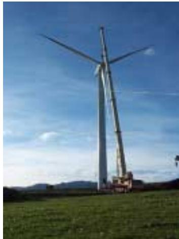
TERMINO MONTAJE PRIMERA TURBINA
