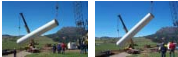
MONTAJE : SECUENCIA DE INSTALACION PRIMERA SECCION DE TORRES
