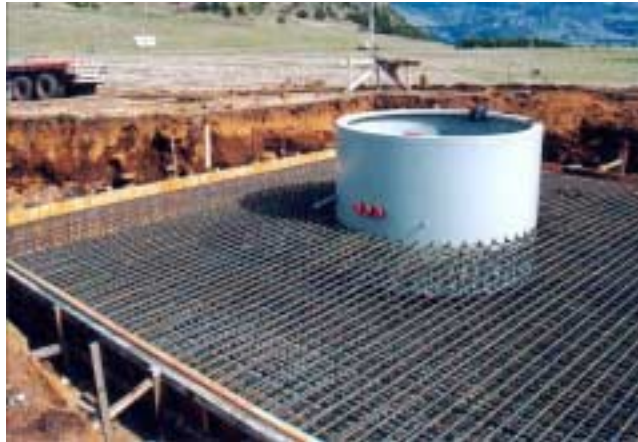
ANILLO DE FUNDACION Y ENFIERRADURA DE FUNDACION
