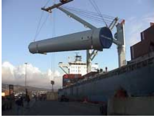
TRANSPORTE- DESCARGA SECCION INFERIOR EN PTO SAN VICENTE
