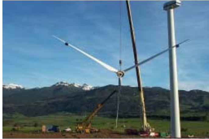
IZAJE DE ASPAS PARA MONTAJE
