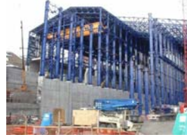
Montaje Industrial Pesado
