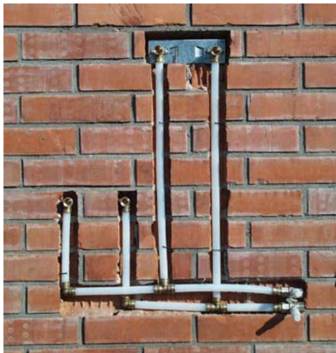
Cañería de PEX para red de agua potable. (Anwo)
