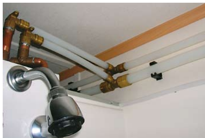
Instalación sanitaria que utiliza fittings y cañerías (Rehau).
