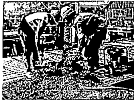
Utilizar vibrador de Inmersión de 35mm
