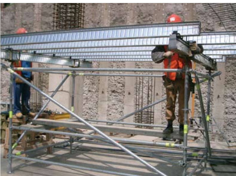
Instalación de un sistema móvil que permite el montaje rápido del encofrado para hormigonar losas y desplazarse en el interior de la obra. (Ulma)
