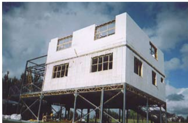
La instalación de ladrillos de poliestireno expandido resulta rápida y simple gracias a su bajo peso: Un metro cuadrado del modelo 250 pesa 3 k y del 125 pesa 1 kilo. (Exacta)
