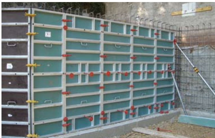
Moldajes en base a planchas plásticas reciclables provenientes de Asia. Alta impermeabilidad (DOM)
