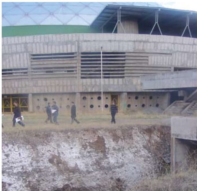
Visita de diagnóstico al estadio antes de la remodelación, donde se apreció la conservación de una sólida estructura de hormigón armado y una cúpula flamante. Sin embargo, el entorno estaba en malas condiciones.
