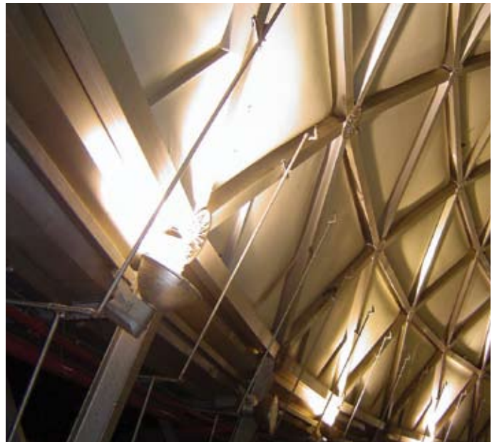
Direccionando la luz hacia arriba, los focos ubicados en el borde de la cúpula aprovechan la superficie reflectante potenciando la altura del edificio. (Foto der.) En el exterior un sistema de iluminación especial permite reflejar mensajes sobre la cúpula. (Foto izq.)
