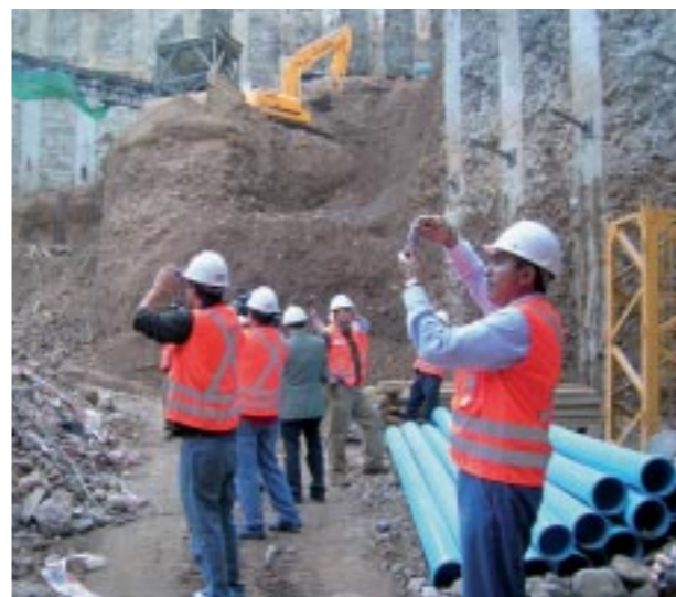
Profesionales del sector recorren la excavación del edificio Territoria 3000, la más profunda de Santiago.
