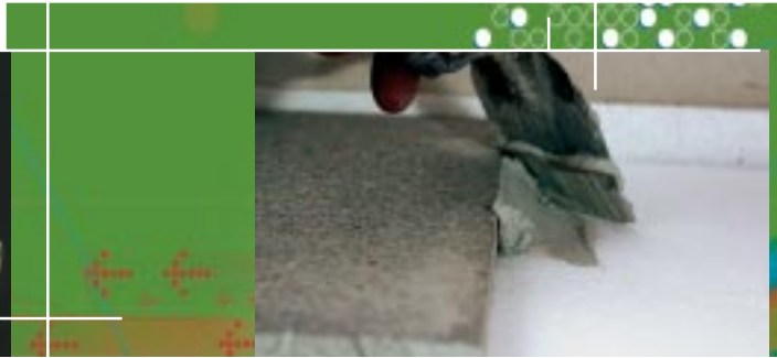
Mortero con propiedades autonivelantes en base a cementos hidráulicos (Thomsit DX).
