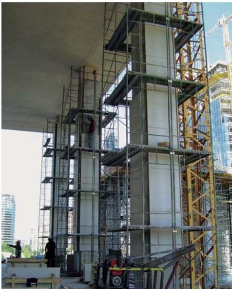
El atrio de 11 m se construyó por medio de moldajes especiales que agilizaron las faenas y torres para alcanzar las losas.
