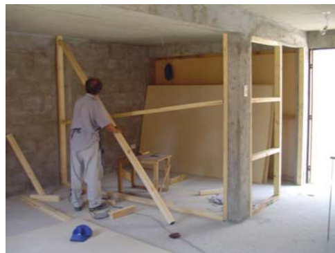
La construcción se centró en la obra gruesa.
