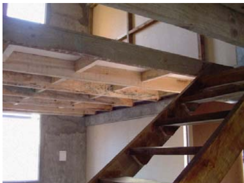
Los duplex reciben suficiente luz al no tener pasillos en frente.
