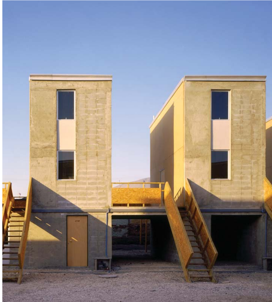
Las casas de altos crecen verticalmente en el piso superior y horizontalmente en el primer piso.
