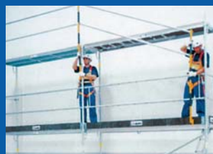
Colocar las plataformas y repetir la operación del punto (x) tantas veces como sea necesario hasta terminar el montaje.
