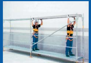
Colocar las plataformas y sus pasadores de seguridad.
