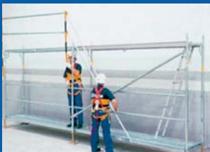
Colocar el pie de seguridad desde el nivel protegido. (x)
