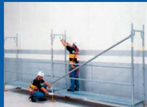
Comprobar la separación de la fachada. Nivelación horizontal y vertical del andamio.
