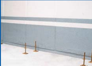
Colocar los husillos sobre los tacos de madera.
