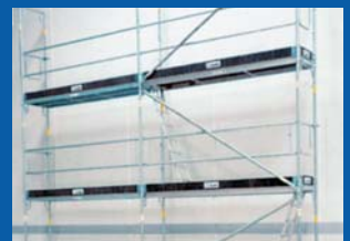
Colocar los marcos, las barandillas, los rodapiés y la diagonal.
