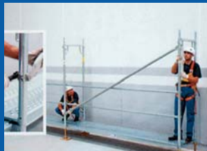
Colocar la diagonal con abrazadera.
