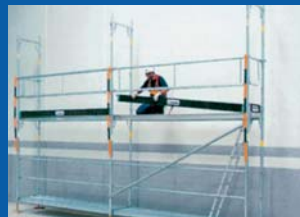
Colocar las barandillas y los rodapiés.
