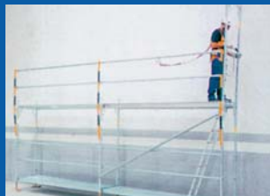
Colocar los marcos. Utilizar protección individual.
