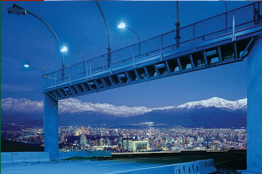
Autopista Costanera Norte.
