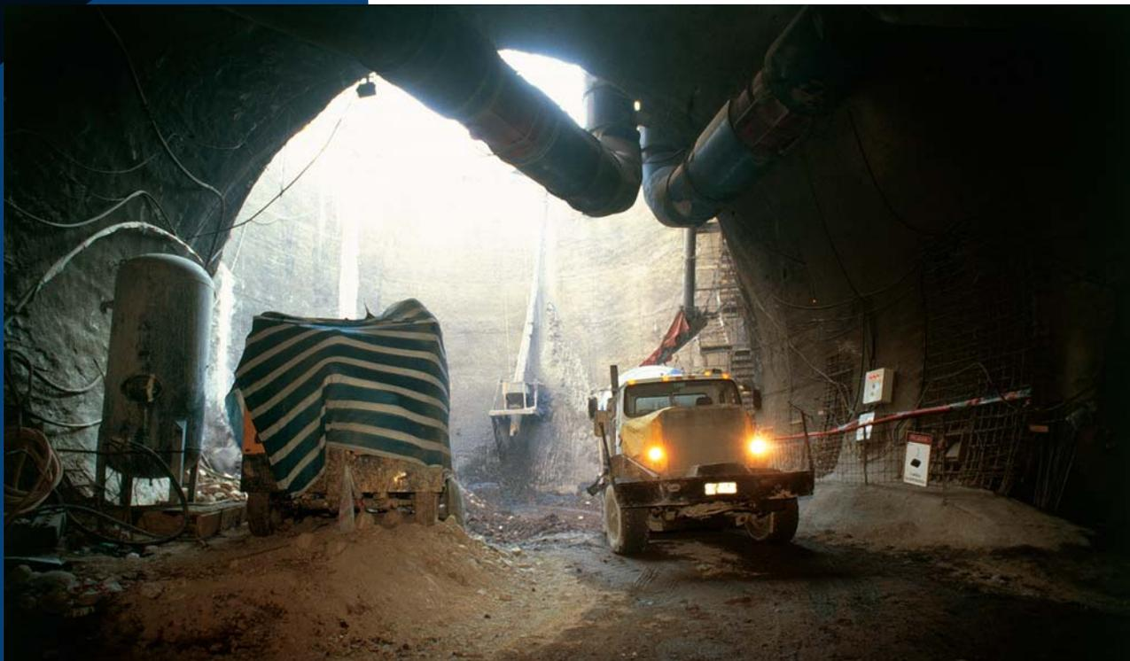
La innovación no siempre se observa a simple vista. En algunas ocasiones actúa a varios metros de profundidad, por ejemplo permitiendo la construcción de un túnel sin alterar el normal desarrollo de una ciudad. Esto ocurre en la aplicación en nuestro país del New Austrian Tunneling Method - Nuevo Método Austríaco de Túneles (NATM), un método de diseño y construcción surgido en Europa en la segunda mitad del siglo XX y que consiste en una excava-
