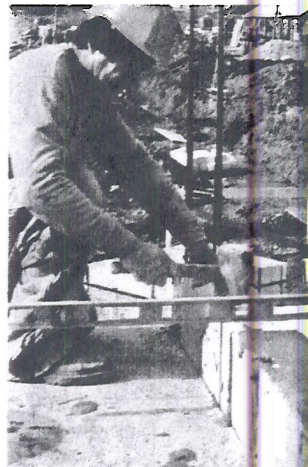
Proceso de instalación bloque celular.
