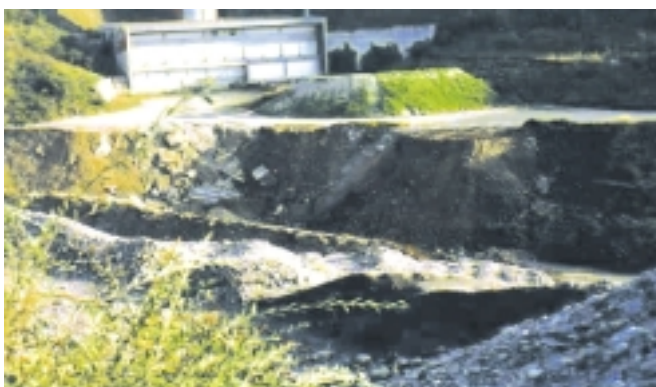
Lenzburg: Pozo para disposición de residuos sólidos inertes
