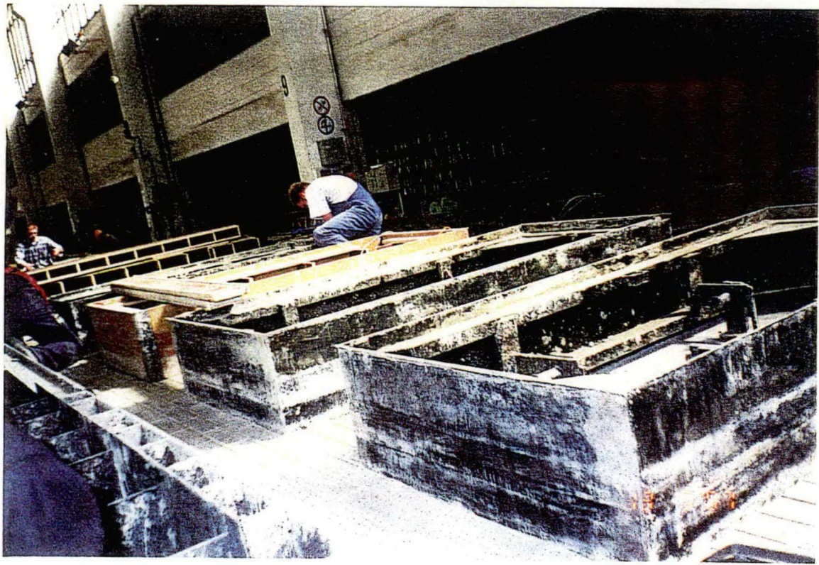
PREPARACION MUDAJE Y VANOS PARA PREFABRICADOS
