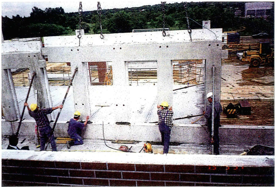
MONTAJE PANTADAS PREPRTRIVADAS CENTRO COMERCIAL, IMBASU - ALEMANIA
