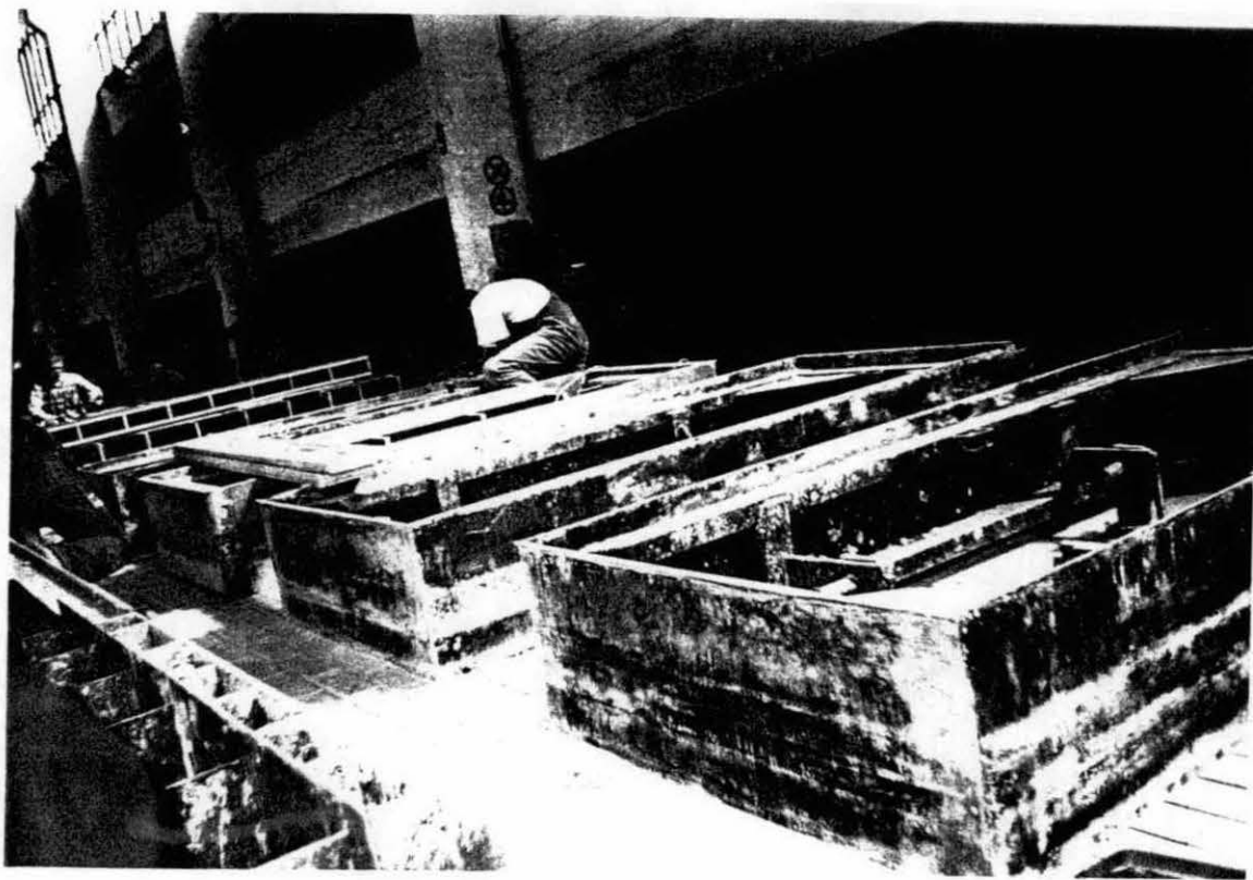
PREPARACION MOLDAJE Y VANOS PARA PREFABRICADOS
