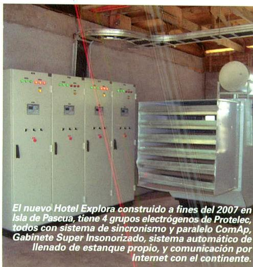
El nuevo Hotel Explora construido a fines del 2007 en Isla de Pascua, tiene 4 grupos electrógenos de Protelec, todos con sistema de sincronismo y paralelo ComAp, Gabinete Super Insonorizado, sistema automático de llenado de estanque propio, y comunicación por Internet con el continente.
