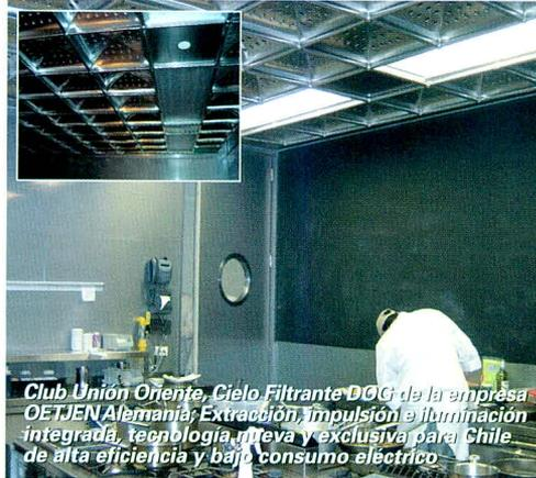
Club Unión Oriente, Cielo Filtrante DDC de la empresa OETJEN Alemania; Extracción, impulsión e iluminación integrada, tecnología nueva y exclusiva para Chile de alta eficiencia y bajo consumo eléctrico
