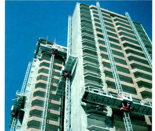
Luego de un arduo trabajo en investigación y desarrollo, **INPROMAS** ha logrado desarrollar la primera máquina para trabajo en altura capaz de elevar personas y materiales hasta 120 m sobre una plataforma modular de 30 m de longitud con 2000 Kg. de capacidad, resistente a movimientos sísmicos, ideal para ejecutar trabajos en fachadas de cualquier tipo de construcción, tales como: enchapes, pinturas, instalaciones, reparaciones, restauraciones, remodelaciones, etc.
