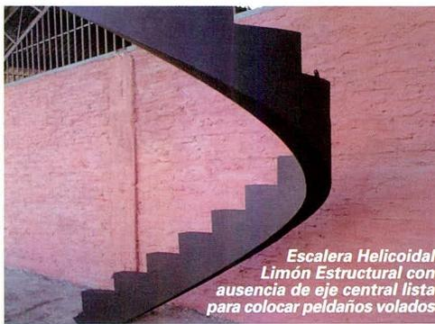
Escalera Helicoidal Limón Estructural con ausencia de eje central lista para colocar peldaños volados
