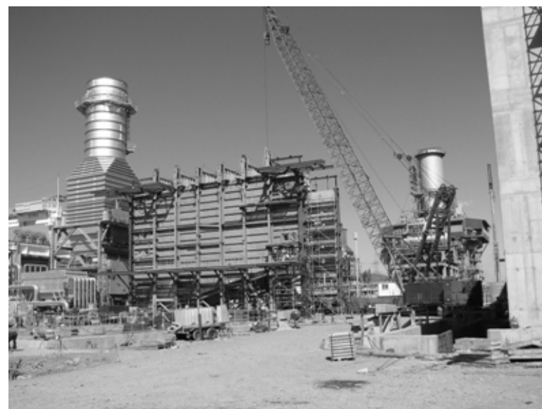
Montaje estructuras caldera
