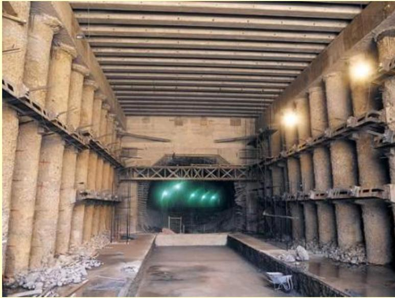
Anclajes Postensados y Pilotes Perforados
