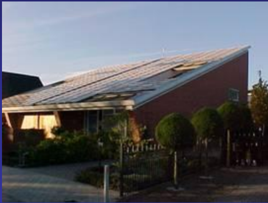
Casa y Techo con Paneles
