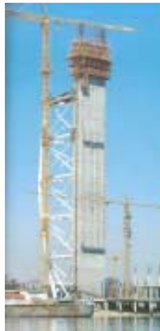
Torre Vasco da Gama Portugal, 122 m
