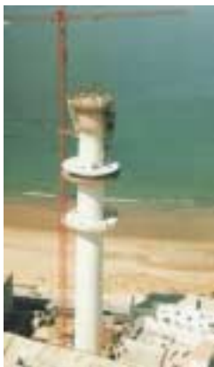
Torre de telecomunicaciones Cadiz, España, 114 m
