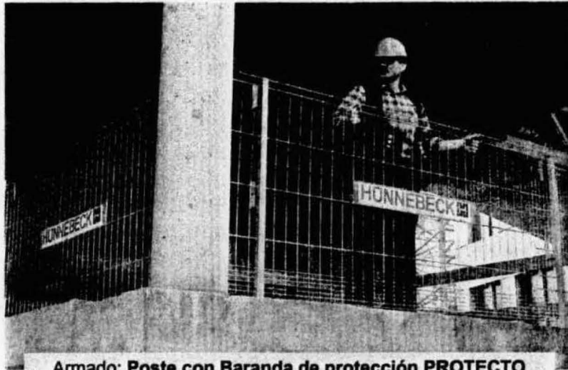
Armado: Poste con Baranda de protección PROTECTO
