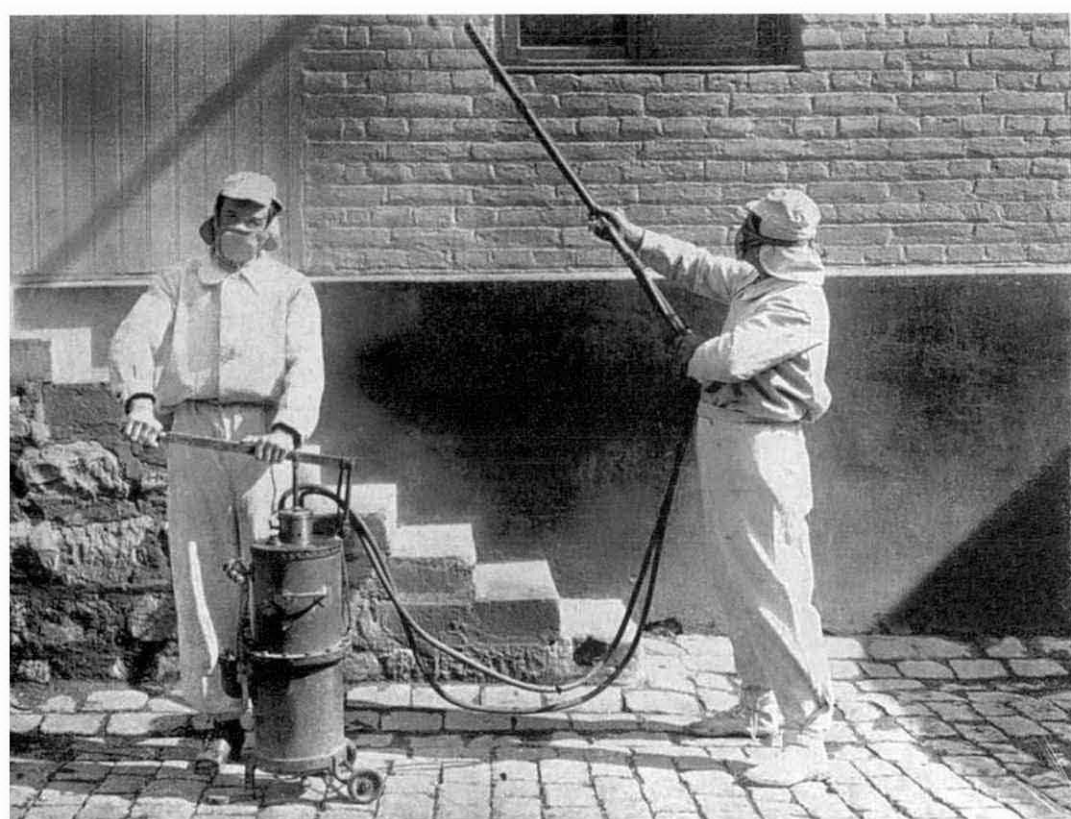
Desinfectorio para sanear las habitaciones obreras existentes, 1900
