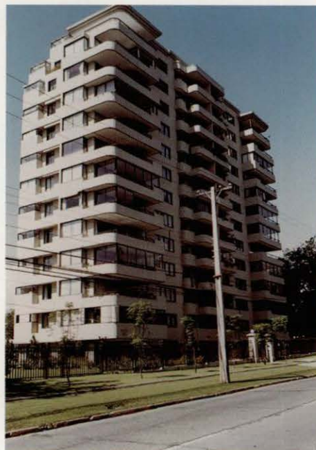
Fotografía inferior: Moller y Pérez Cotapos, Edificio Bilbao.
