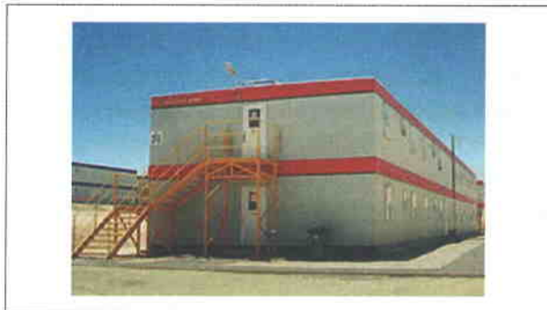
Ilustración 25 Instalaciones de campamentos
