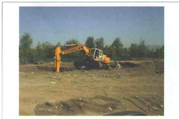
Ilustración 2 Excavación a máquina
