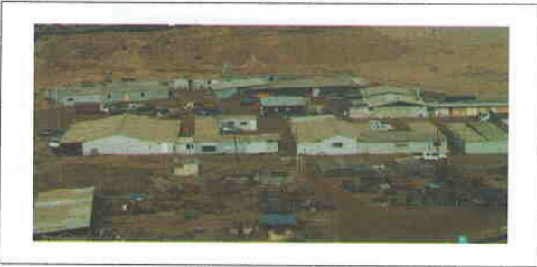
Ilustración 13 Vista panorámica instalación de faenas
