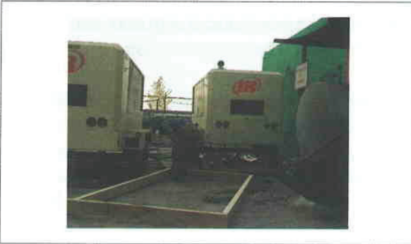
Ilustración 18 Preparación capa de arena
