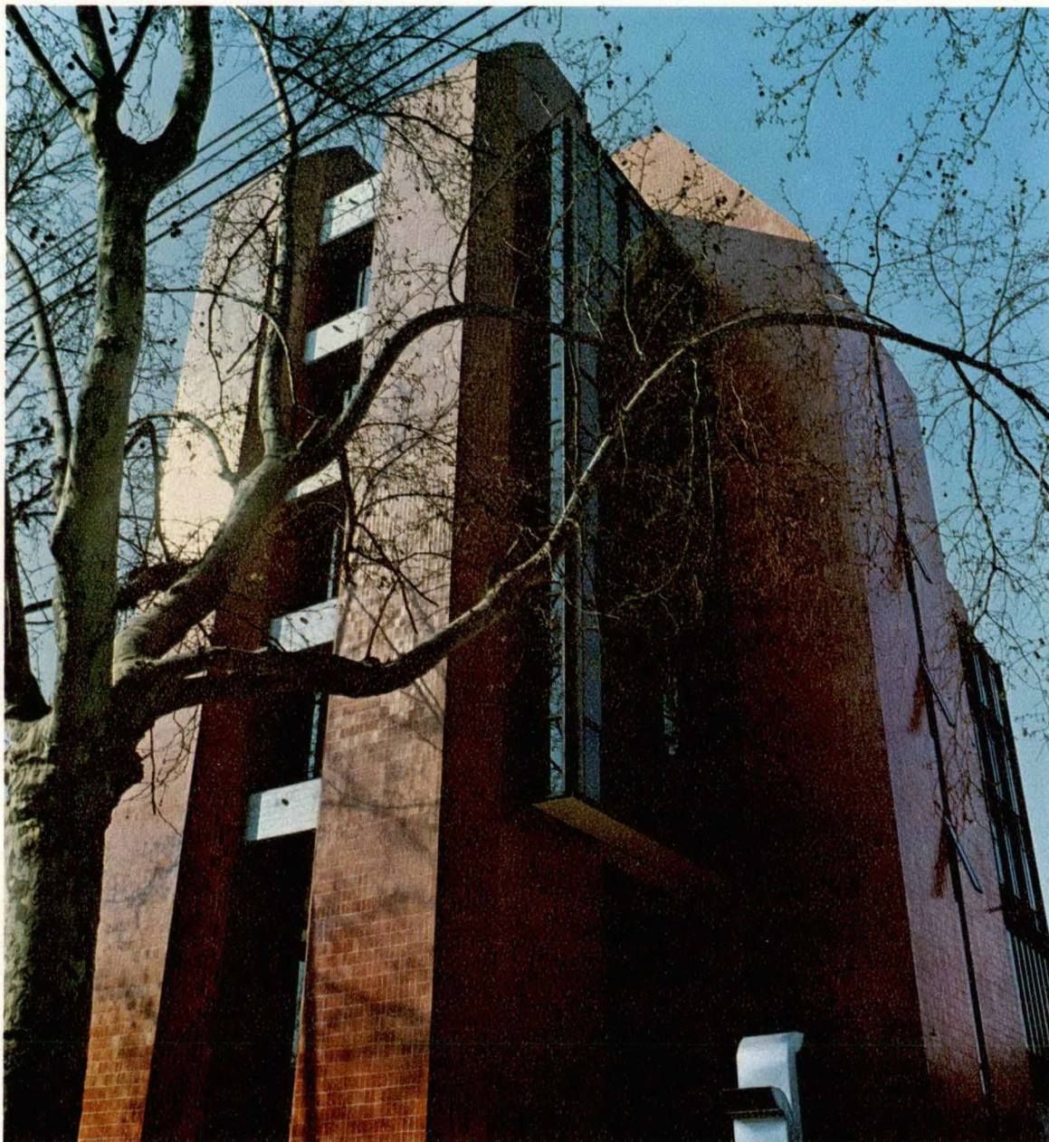
Modernización y Funcionalidad.
