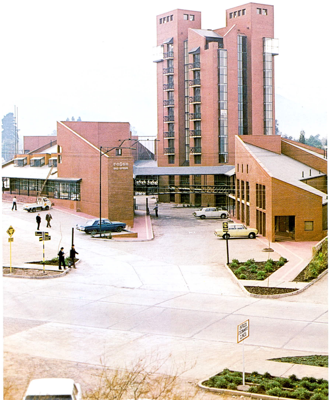
Foto 3 Centro Comercial Pueblo del Inglés, en Santiago. Su urbanización y construcción se realizaron en 12 meses. El proyecto arquitectónico fue premiado en la Bienal de Arquitectura de Quito (Ecuador) de 1980.
