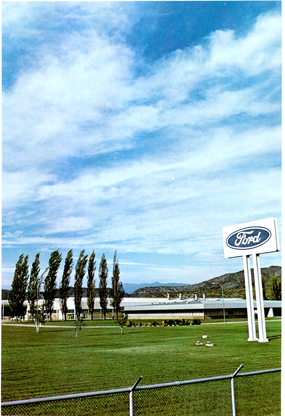
Foto 3 Planta Ford - Casablanca. Construcción, urbanización e Instalaciones especiales.
