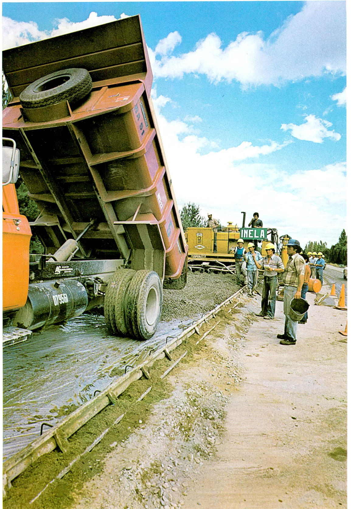
Foto 3 Repavimentación Carretera Panamericana Villa Alegre - Linares.
