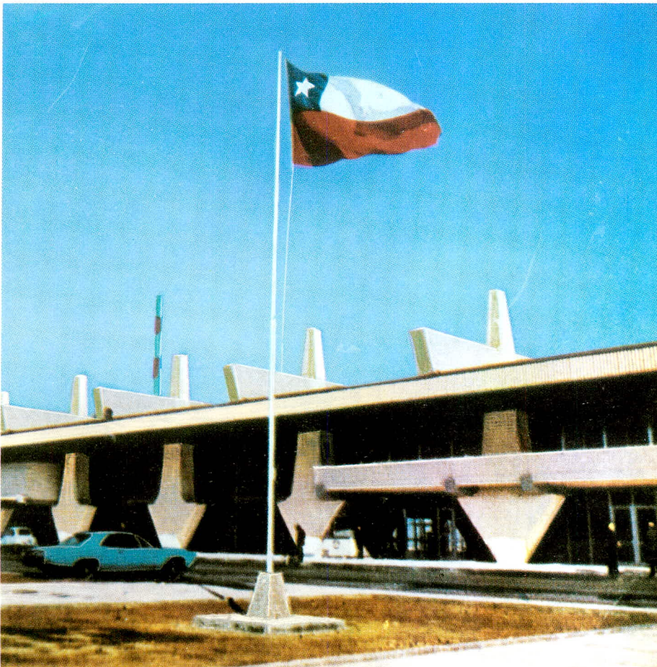
Foto 1 Paso superior Malloco Autopista Santiago-San Antonio.
