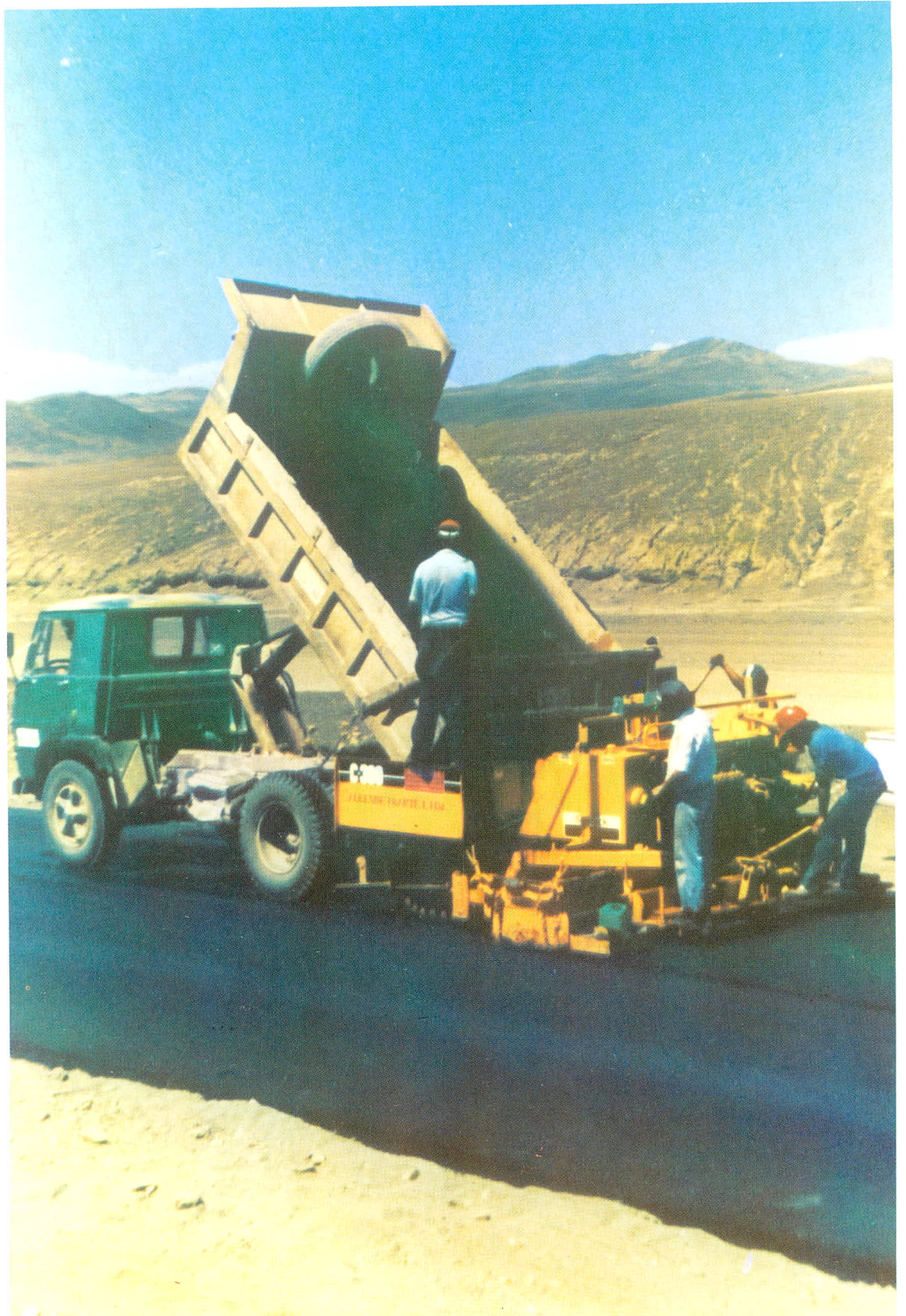
Foto 3 Panamericana Norte, mezcla asfáltica.
