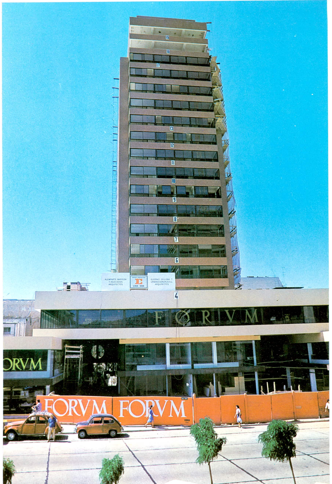
Foto 3 Edificio de Oficinas en calle Pedro de Valdivia 295.
