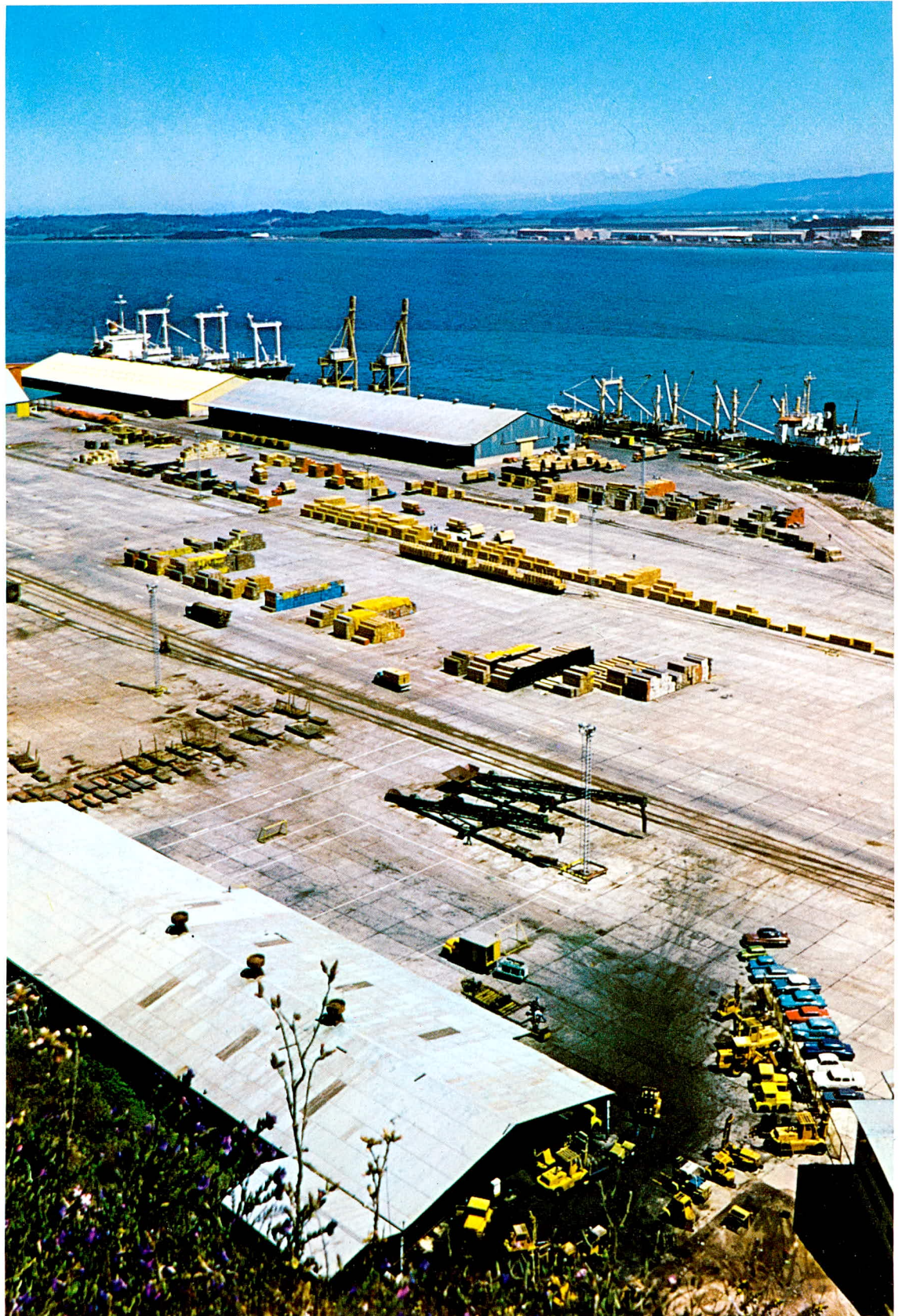
Foto 3 Obras Civiles y Portuarias del Puerto de San Vicente, Talcahuano, uno de los principales puertos chilenos, donde Sigdo Koppers fue el Contratista General.
