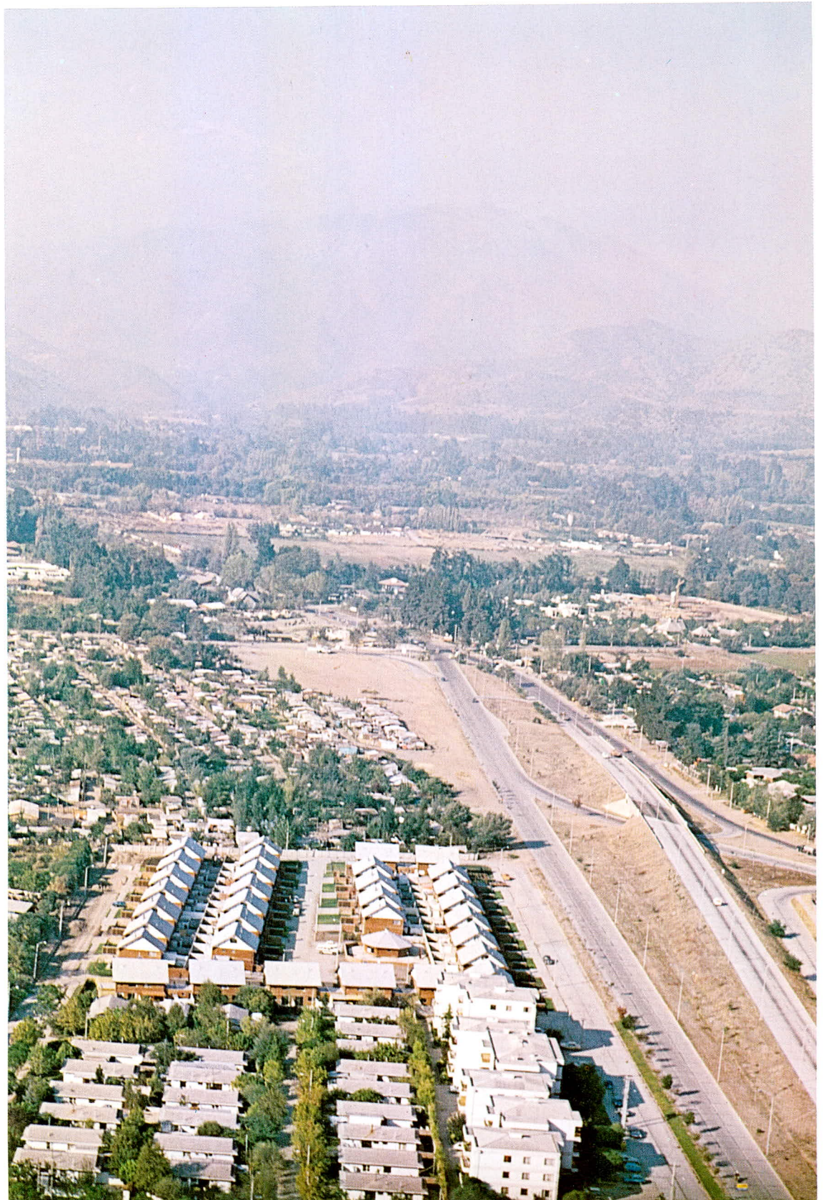
Foto 3 Conjunto habitacional La Aurora. Av. Kennedy alt. 9612.
