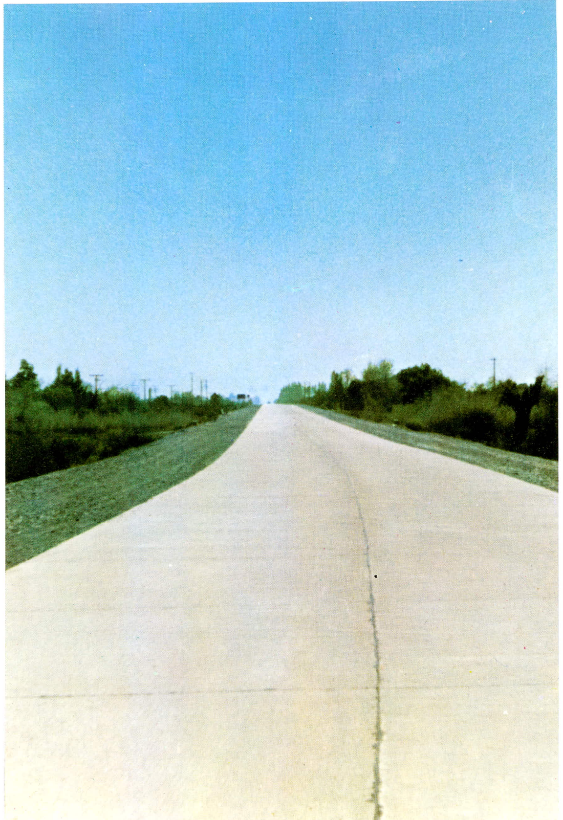
FOTO 3 Repavimentación Carretera Longitudinal Sur Sector Vi- lla Alegre - Perquilauquén.
