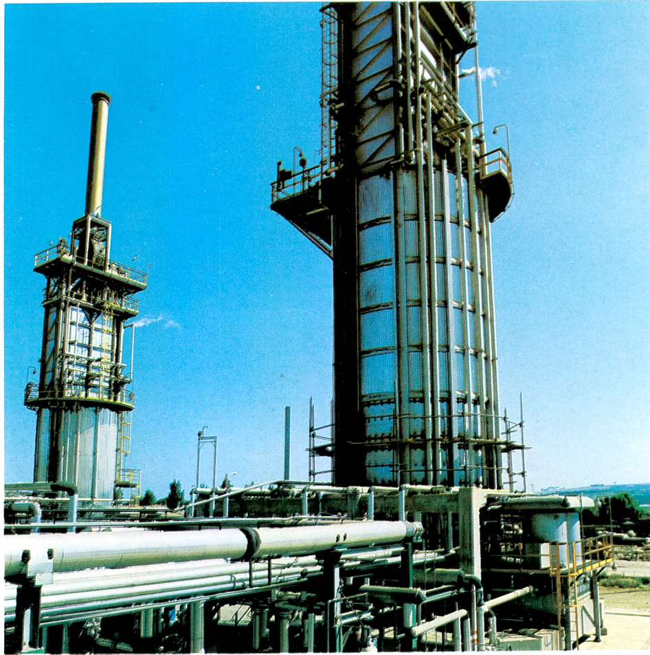
Foto 3 Remodelación Topping N° 1 Refinería ENAP- Concon
