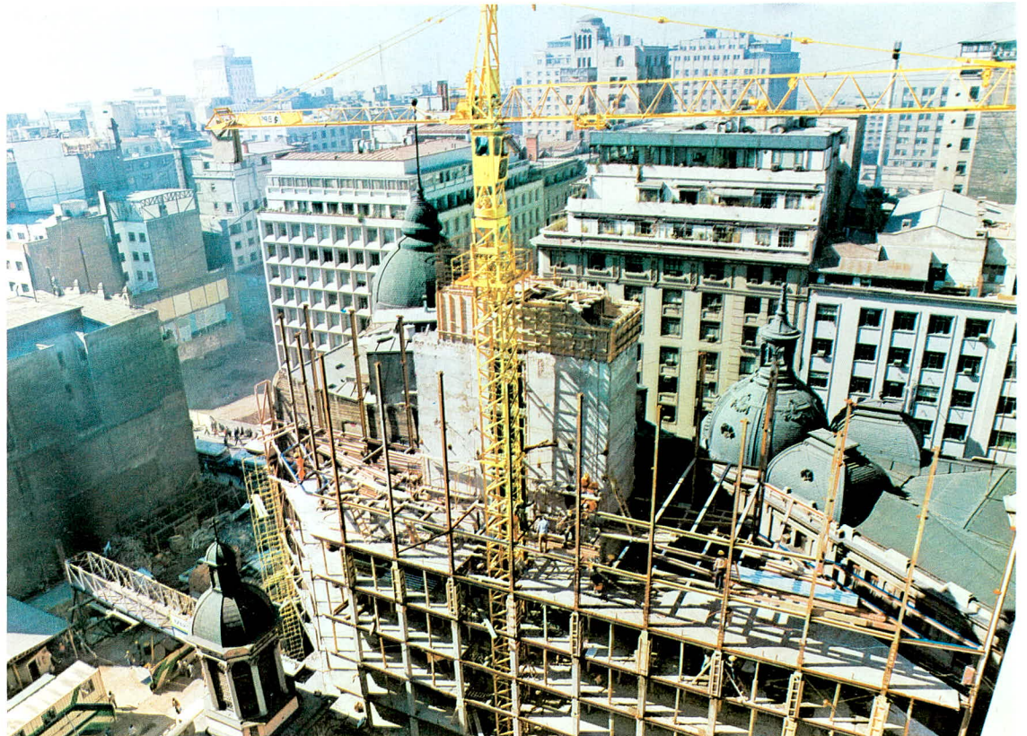
Foto 4 Edificio en Estructura de Acero Moneda 1062 Santiago
