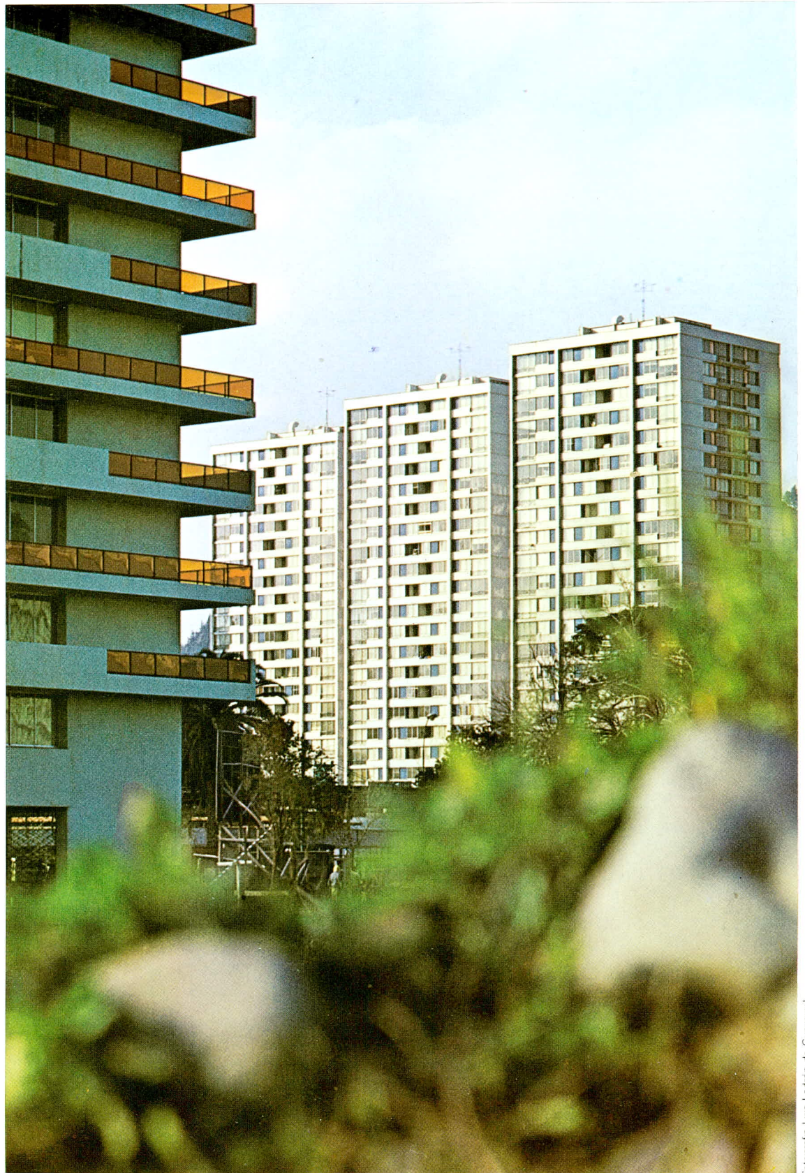
Foto 3 Remodelacion San Borja. Santiago. 55.000 m2 edifi- cados. 500 departamentos. 4 torres. 22 pisos, super- mercado, locales comercia- les y estacionamientos.
