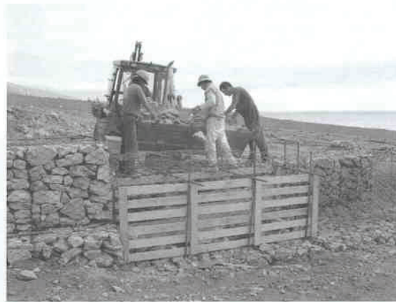
Fig. 5.11 a) y b) Traslado de Material de relleno y llenado
