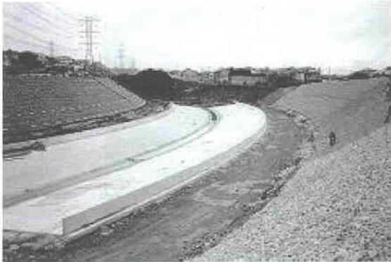
Fig. Nº 2.12 Recubrimiento de canales con gaviones sábana
