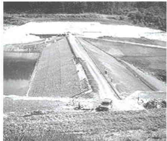
Fig. N° 2.11 Diques y Protección de represas en gaviones
