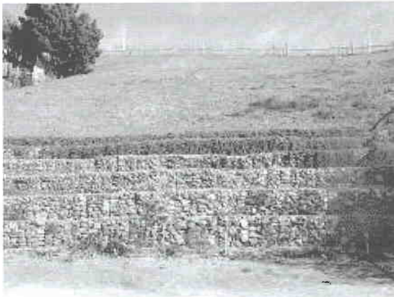
Fig. N°2.6 Cobertura vegetal sobre muro de gaviones
