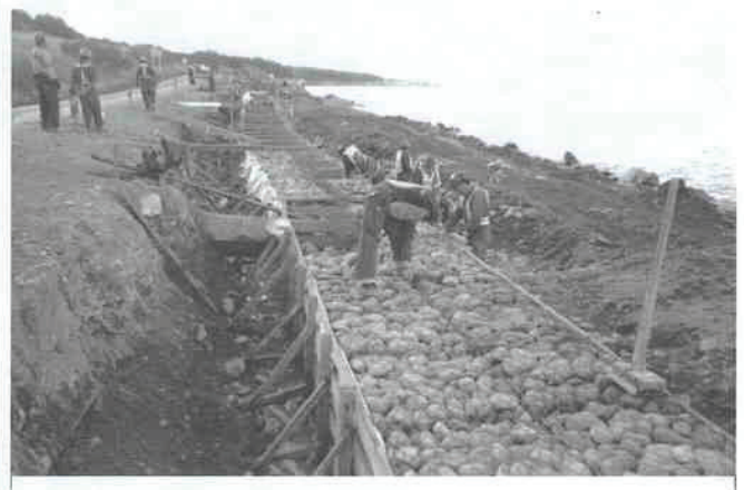
Fig. 5.12 a) y b) y c) Utilización de Moldajes y Geotextil en obra en gaviones
