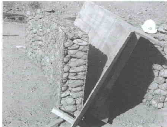
Fig. N°2.4 Gavión especial realizado con moldaje curvo
