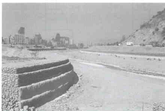
Fig. 3.36 a) y b): Revestimiento con shotcrete y disipadores de energía para protección de las mallas en gaviones Río Mapocho
