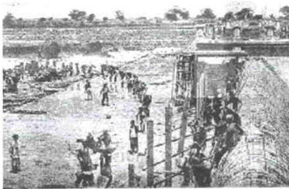
Figura N°1 Construcción en Italia de obra en gaviones siglo XIX
