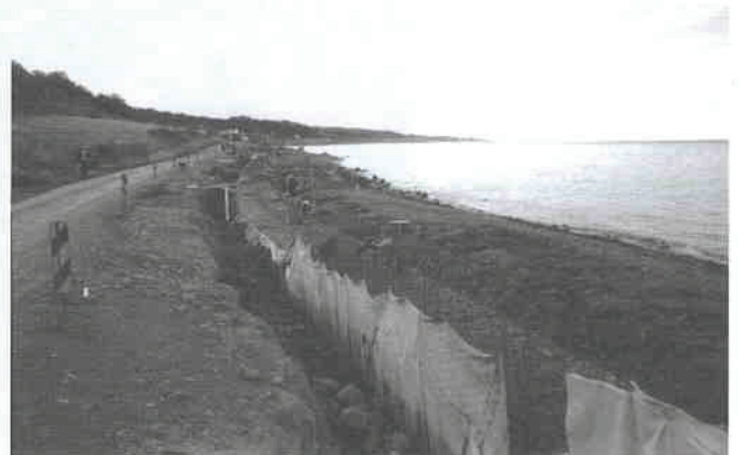
Obra: Protección Camino San Juan. Punta Arenas MOP Vialidad. 2003
