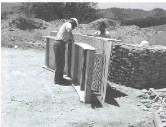
Fig. N°2.4 Gavión especial realizado con moldaje curvo
