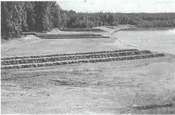
Fig. Nº 2.13 Espigones con gaviones
