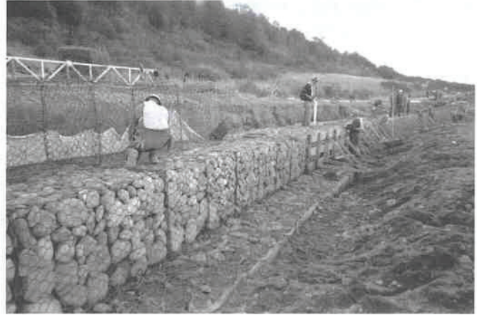
Fig. 5.12 a) y b) y c) Utilización de Moldajes y Geotextil en obra en gaviones
