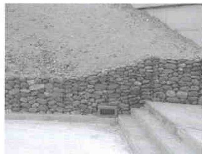
Fig. 3.37 Detalle de interferencia con escalera e iluminación. Se aprecia en la parte superior gavión llenado parcialmente para realizar la transacción
