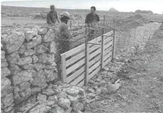
Fig. 5.10 Aplicación de moldajes y fijación de diafragmas
