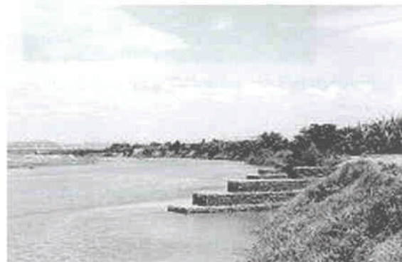
Fig. Nº 2.13 Espigones con gaviones
