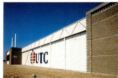
Planta Agroindustrial, Copiapó.
