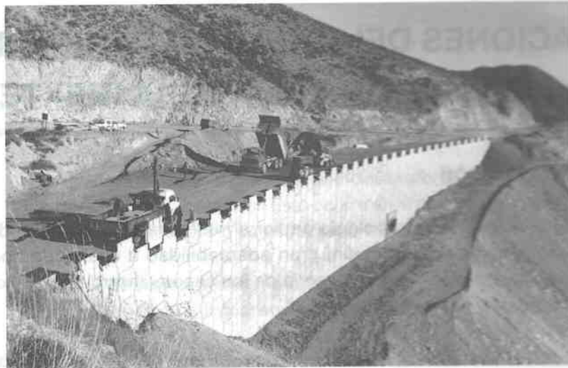
Fotografía 2: Muro camino Arica-Tambo Quemado, Chile
