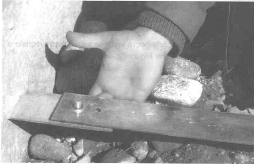
Fotografía 8: Conexión con barra atornillada y perno
