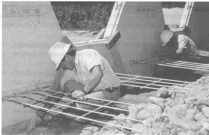
Fotografía 16: Fijación de mallas a placas de hormigón
