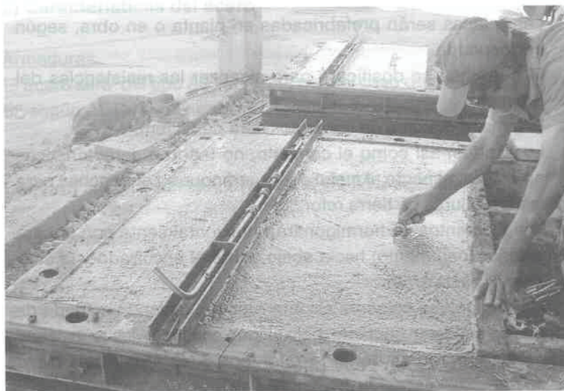
Fotografía 13: Fabricación de placas de hormigón en obra
