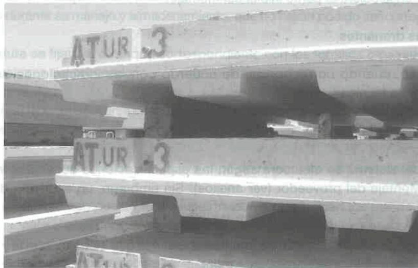
Fotografía 14: Acopio de placas de hormigón
