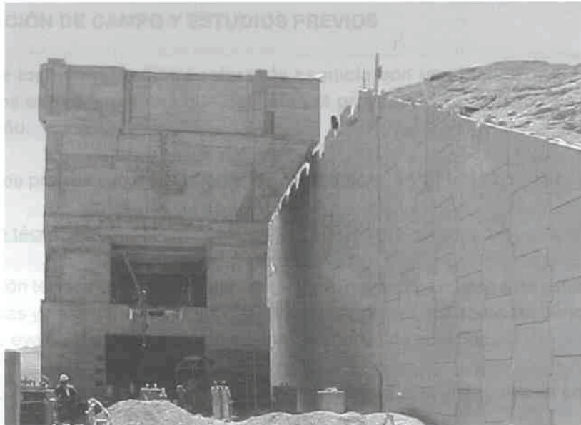
Fotografía 7: Muro chancador El Tesoro, Calama, Chile
