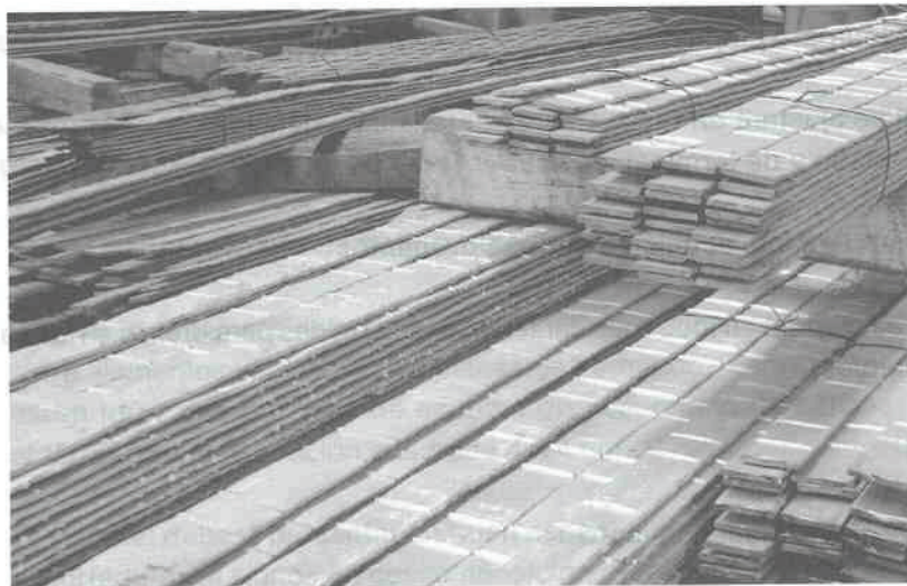
Fotografía 15: Acopio de armaduras
