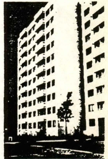
Cimbra integral de PAMA- CON en muros y entrepisos (Alemania).
