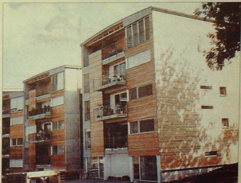
En Suiza, las construcciones en madera son tan populares que se hacen incluso en altura.
