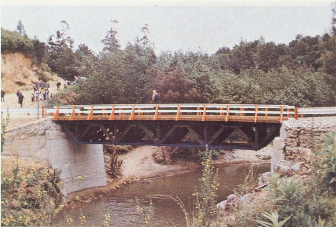
Puente modular prefabricado de madera, instalado en octubre de 1986, en los Quillayes, VIII Región.
