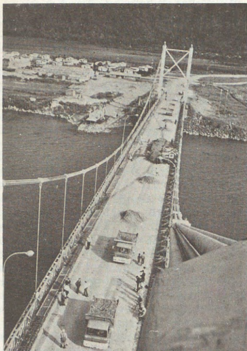
Fig. 11. Vista superior del puente en una de las etapas de carga.
