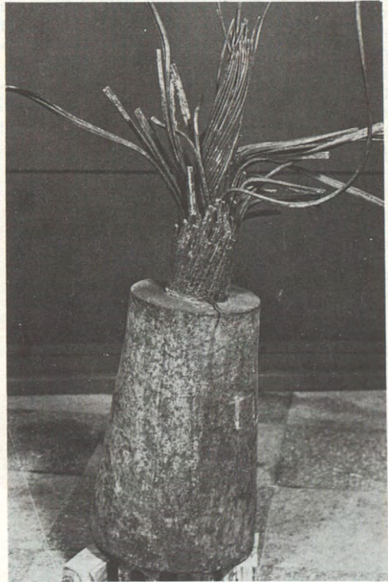
Fig. 6. Zona de rotura del cable, en la profundidad del cono de anclaje.
