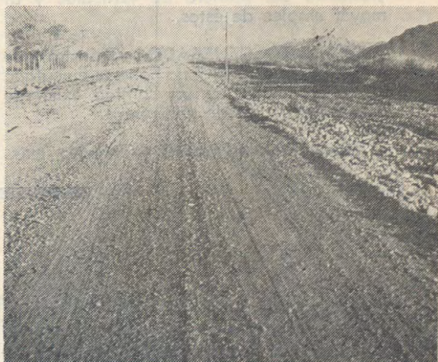
CARRETERA PANAMERICANA EN COPIAPO, SECTOR TIERRA AMARILLA
