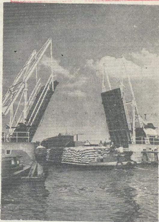
**El transporte fluvial, factor importante en la economía holandesa: Los puentes tendidos sobre ríos y canales constituyen un obstáculo para la navegación fluvial. Por lo tanto, la mayoría de los puentes pueden ser alzados, tal como lo muestra esta foto. El accionamiento eléctrico del mecanismo reduce la demora al mínimo.**
